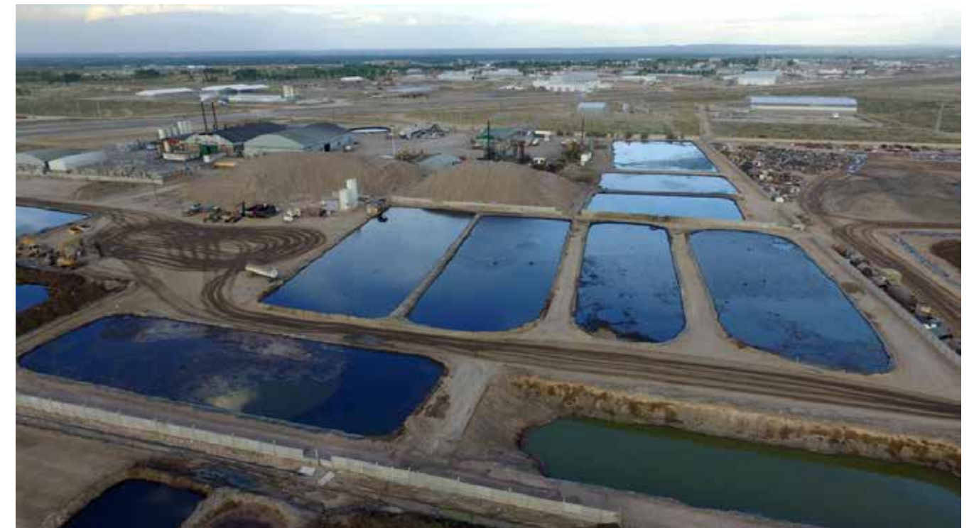
Vista de los piletones de residuos de COMARSA en el PIN, cercano a la ciudad de Neuquén. Fuente: OPSur, 17/12/2020.
